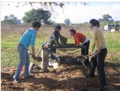
Las mujeres en plena preparación de ladrillos de tierra.
